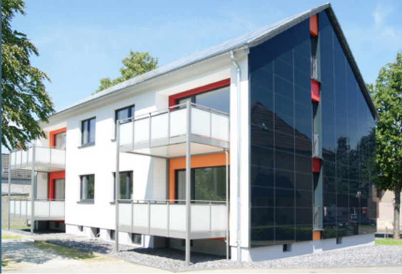
Plusenergie VIVAWEST Zukunftshaus.
